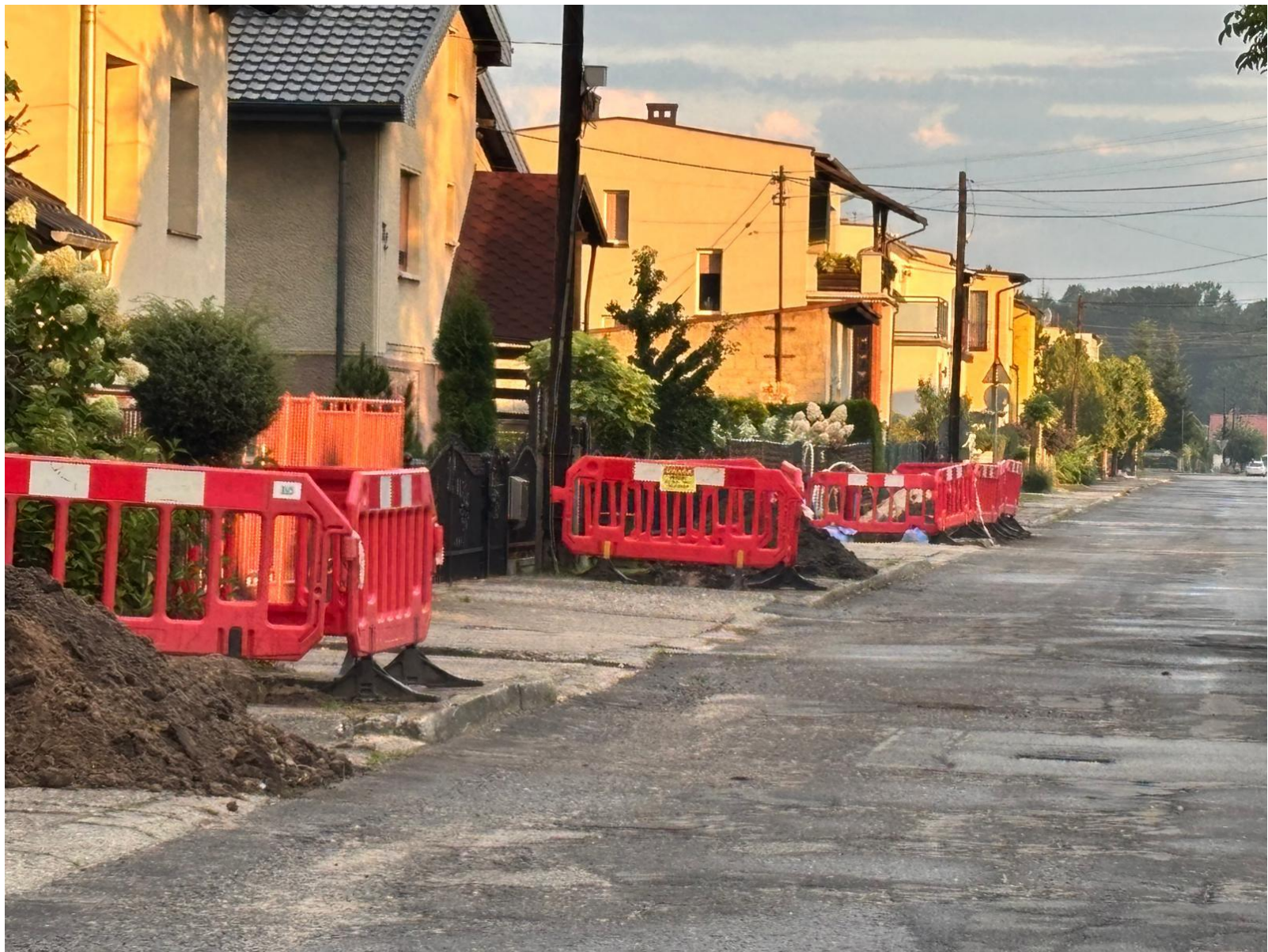
Wymiana sieci wodociągowej w ulicy Moniuszki w Zawadzkiem
