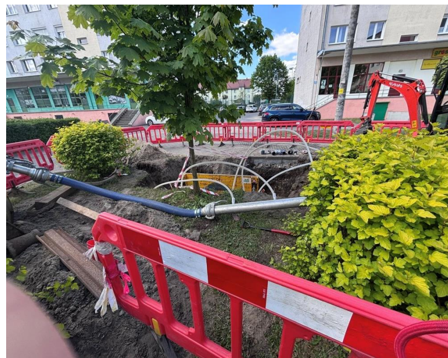
Przebudowa sieci wodociągowej w ul. Powstańców Śl. w Zawadzkiem
