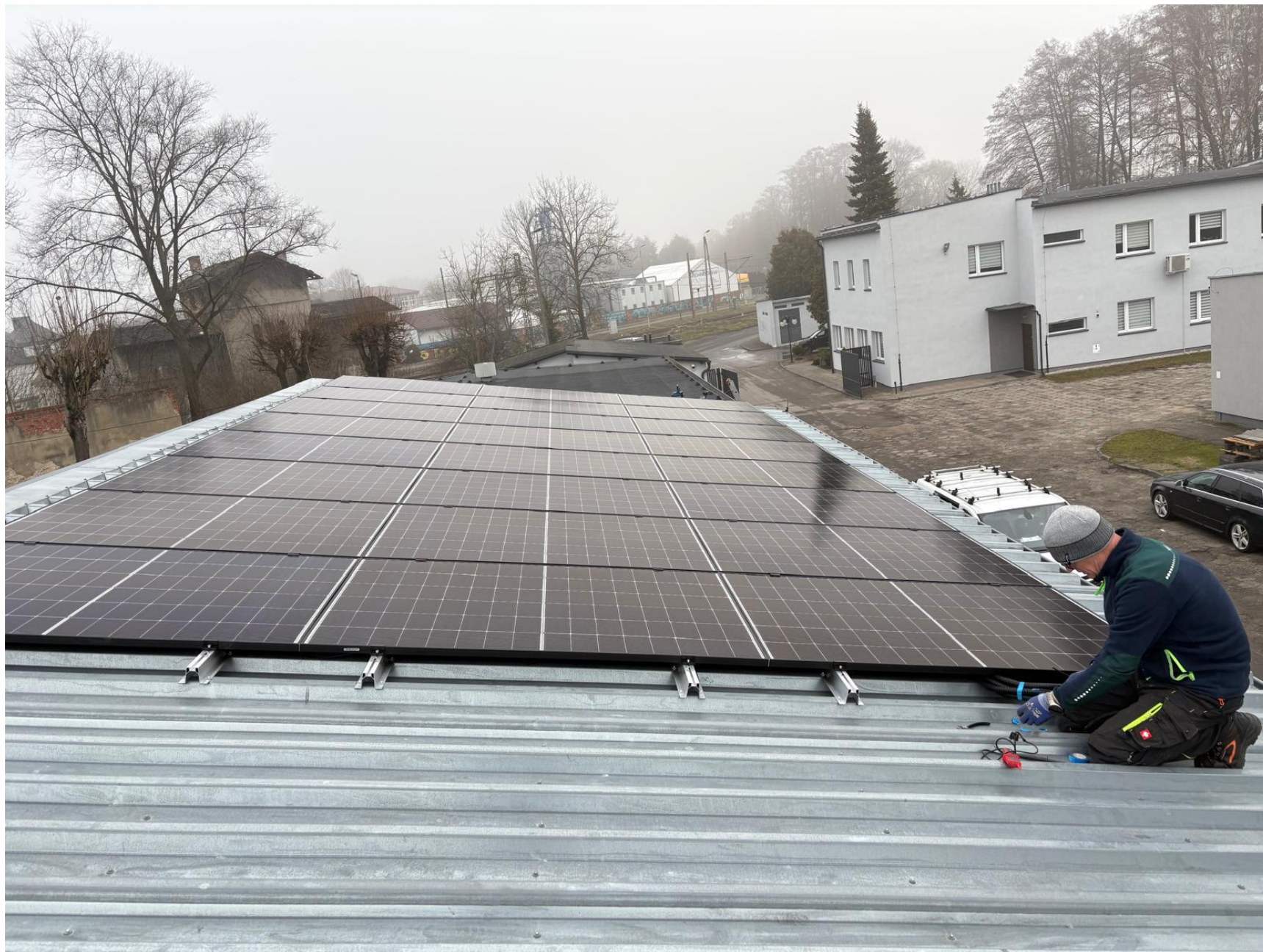
Montaż instalacji fotowoltaicznej
