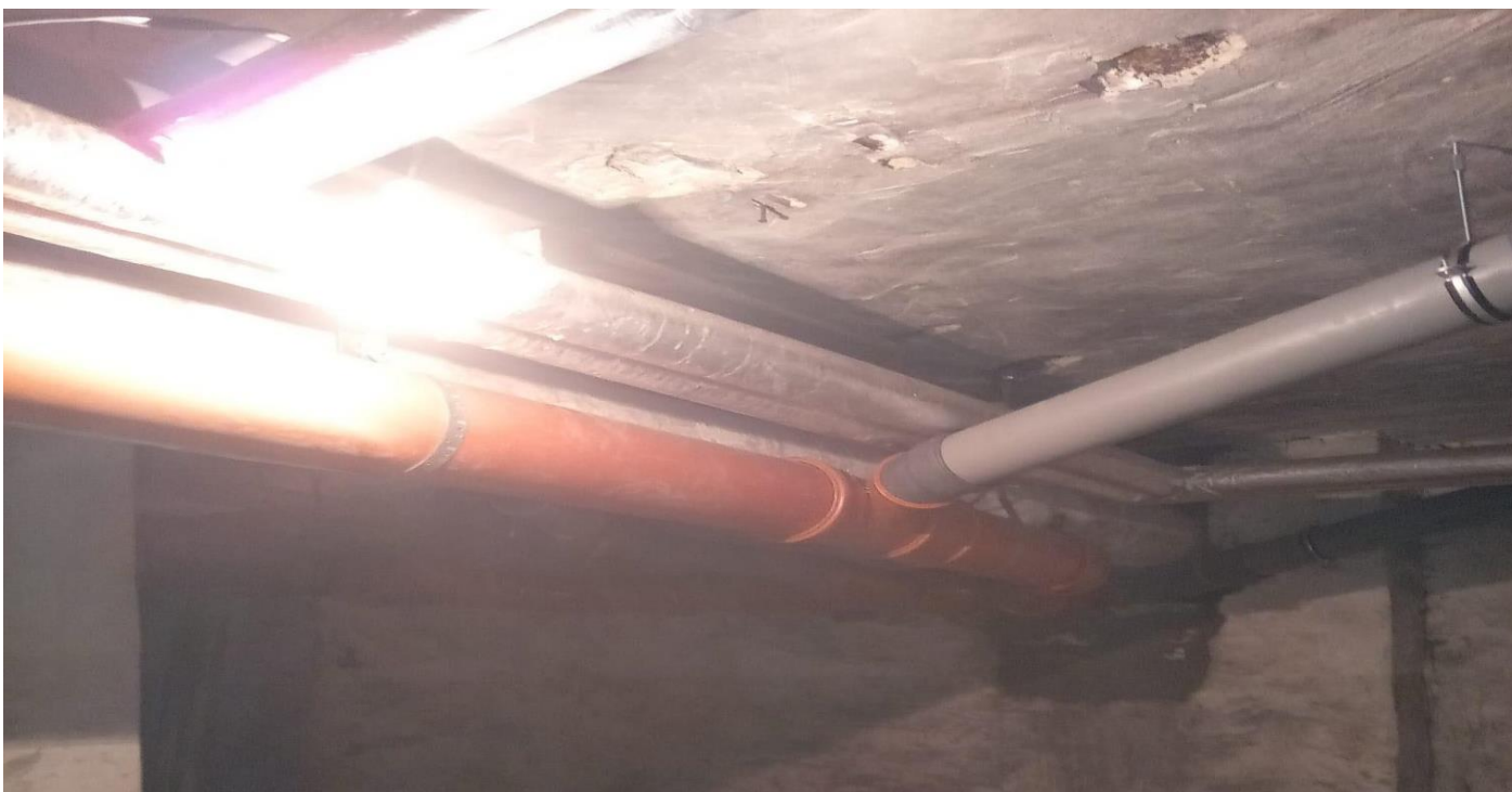
Wymiana starej nieuszczelnej instalacji kanalizacyjnej wewnątrz budynku Domu Kultury przy ul. Dworcowej w Zawadzkiem
