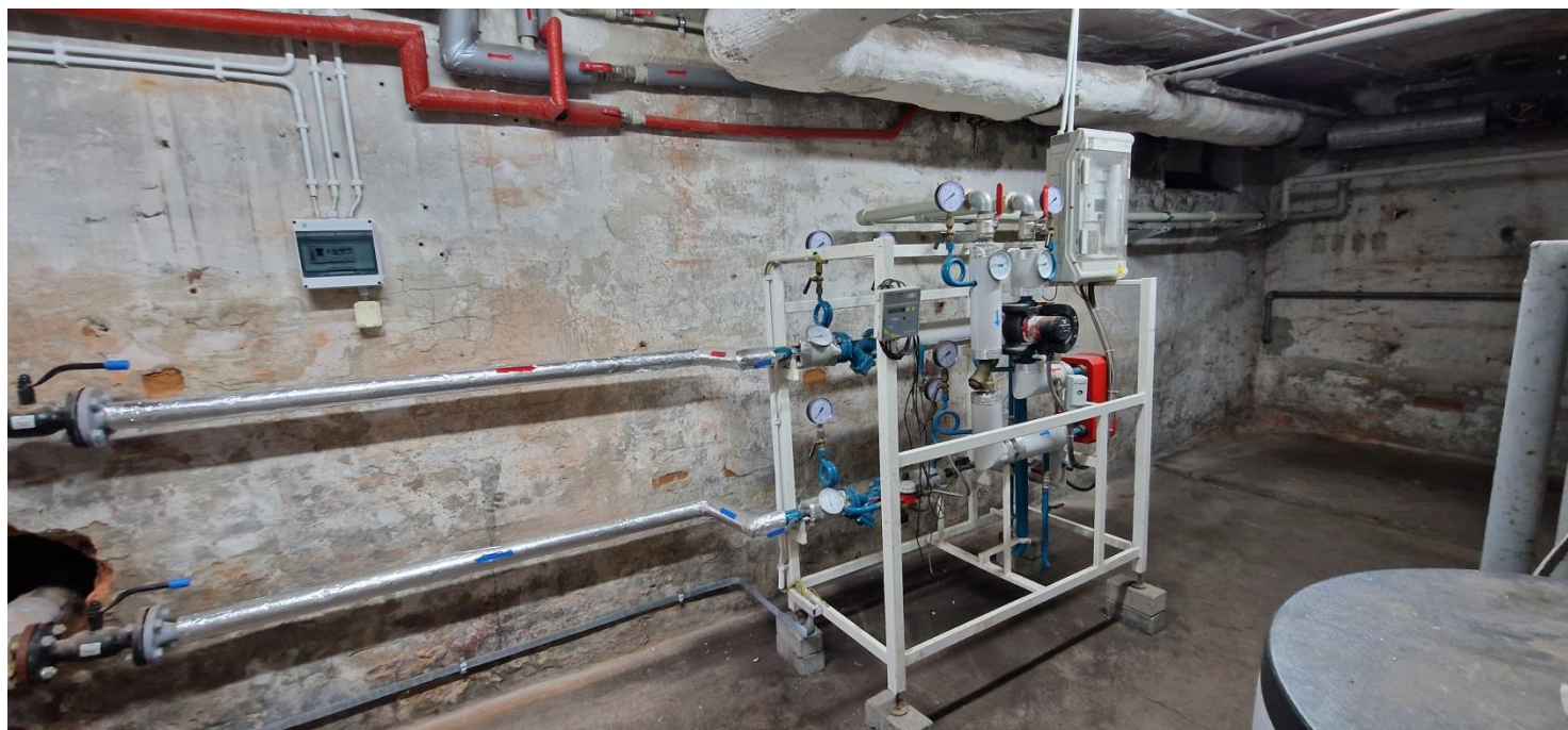
Modernizacja węzła ciepłowniczego w budynku Żłobka w Zawadzkiem
