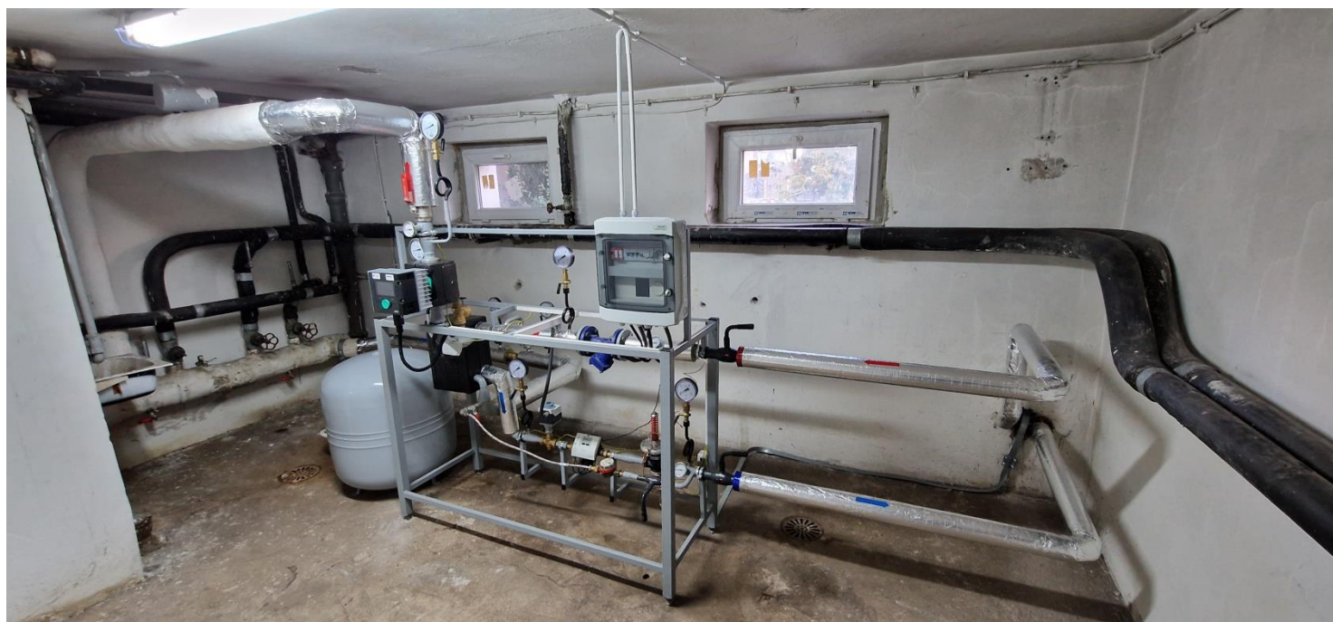
Modernizacja węzła ciepłowniczego w budynku wielorodzinnym w Zawadzkiem
