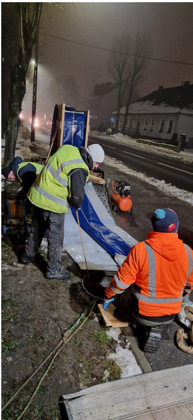
Bezwykopowa renowacja sieci kanalizacji sanitarnej w ul. Opolskiej w Zawadzkiem
