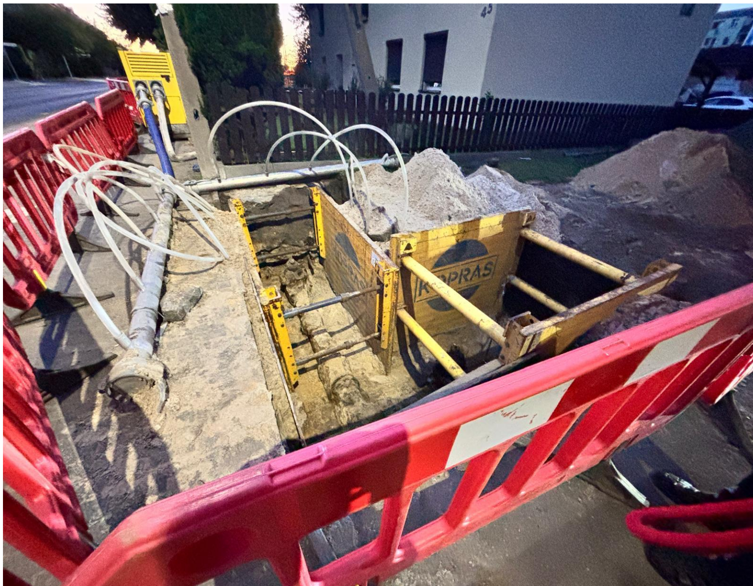
Przebudowa głównego węzła wodociągowego w drodze wjazdowej do Wieży ciśnień w Zawadzkiem
