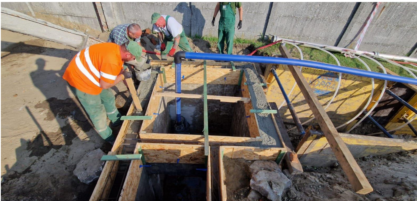
Wymiana sieci wodociągowej i armatury dla studni nr 1 i 1z w Zawadzkiem
