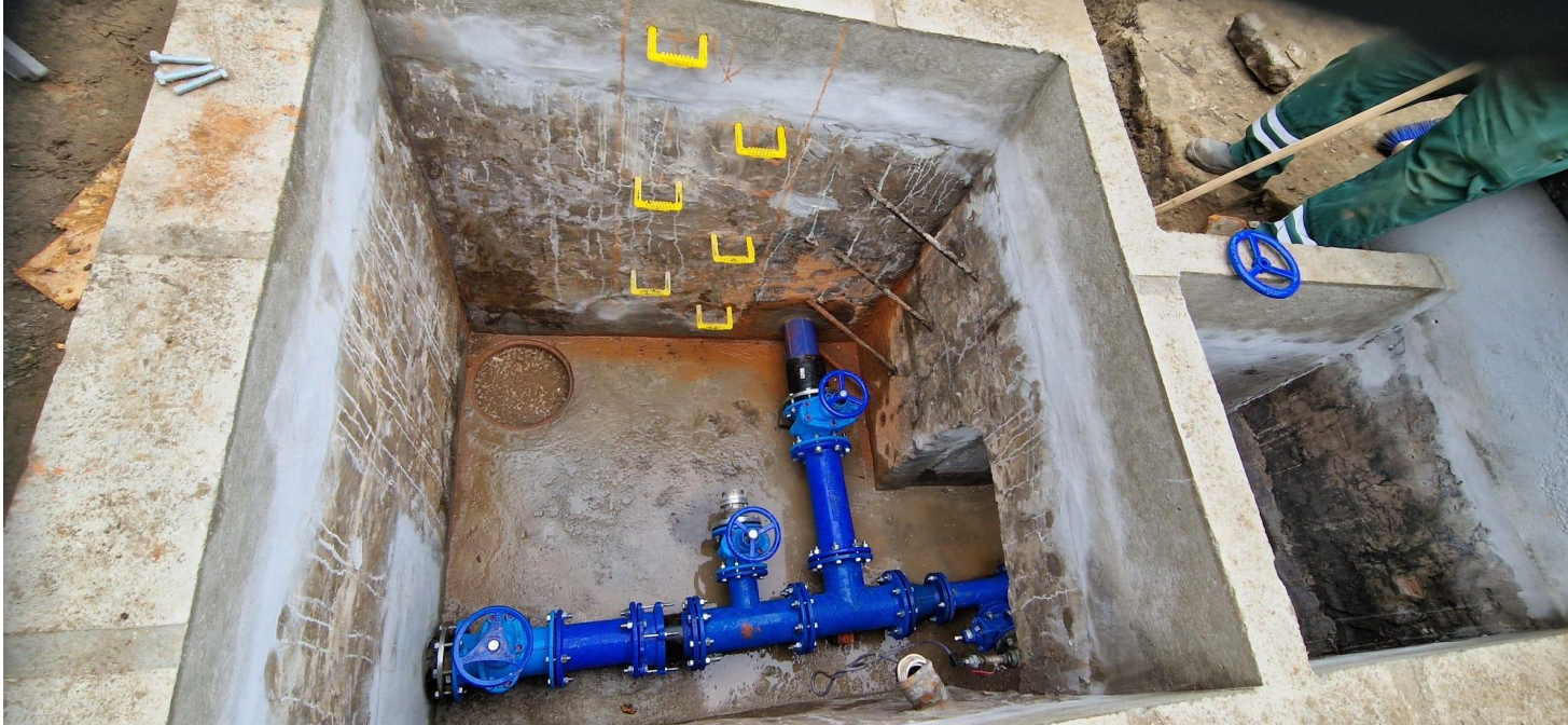
Wymiana sieci wodociągowej i armatury dla studni nr 1 i 1z w Zawadzkiem
